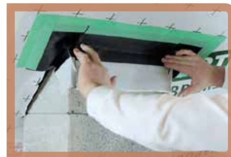
Vnitřní rohy s podomítkovou úpravou
